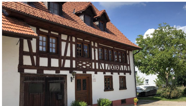
Fachwerkhaus an der Haltestelle des Wanderbusses "Oberdorf" in Ewatingen
